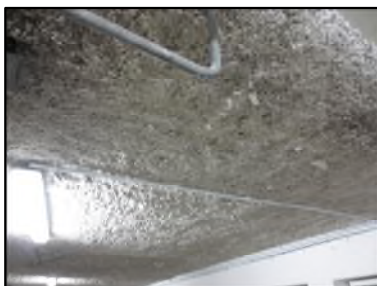
Photo N° 585 ECH-N°1 FLOCAGE -- Parking Plafonds Blanc cotonneux
